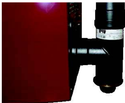
Fig. 49 - Limpieza canal de humos
