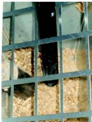
Fig. 46 - Limpieza depósito y coclea
