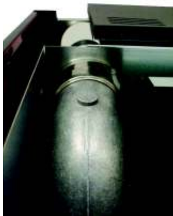
Fig. 33 - Posicionamiento posterior de los tubos
