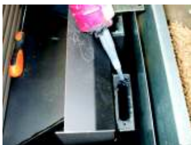
Fig. 60 - Colocación de la silicona
