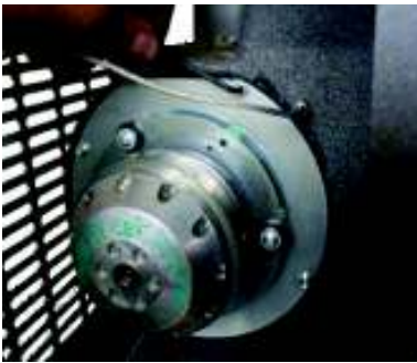
Fig. 50 - Limpieza del aspirador de humos: fase 1
